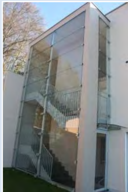
Treppenhaus-Verglasung Ober Tannberg in Schenkon
